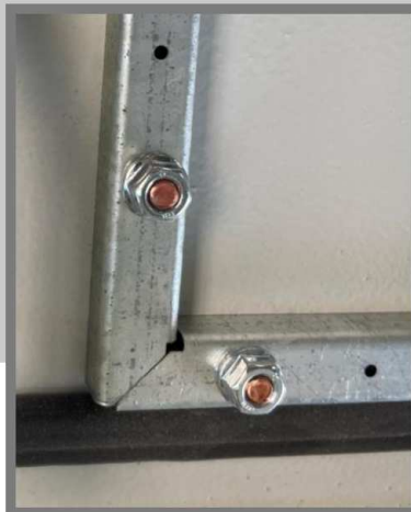
Профили на дверях для установки кабельного канала
